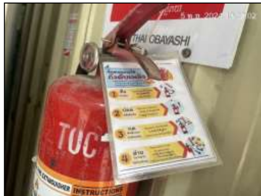
ภาพที่ 36 ถังดับเพลิงเคมี และป้ายแนะนำการใช้งาน
