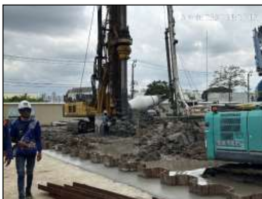
ภาพที่ 74 ก่อสร้างโดยใช้เสาเข็มเจาะ
